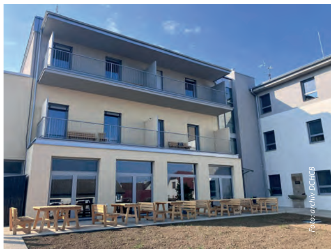
Během 20 měsíců byla vybudována i zcela nová přístavba
